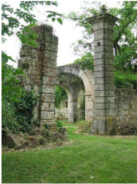
Ruines des écuries.
