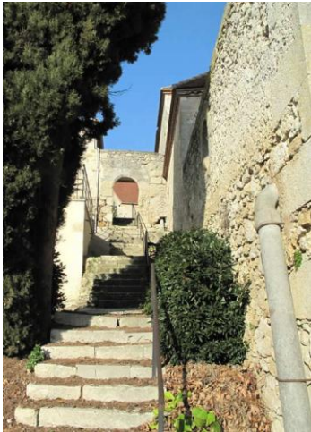
Porte piétonne (vue côté escalier)
