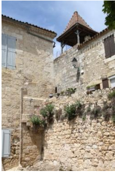
Porte orientale, vue depuis le sud-est.
