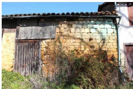
Front sud de l'enceinte (parcelle E 287), vue depuis le sud.
