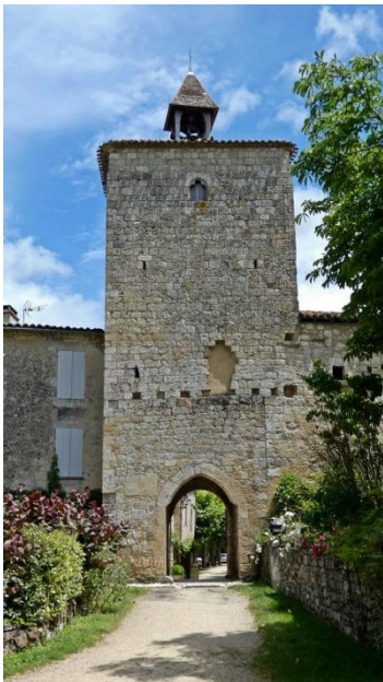
Tour-porte (vue depuis l'ouest).
