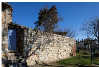
Vestiges d'un mur d'enceinte au sud de la bastide.
